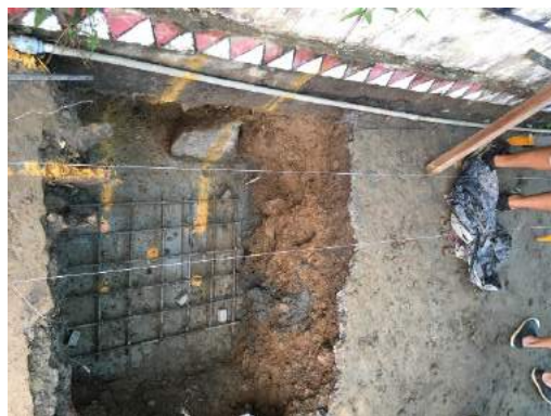
圖二、柱位放樣基準線
