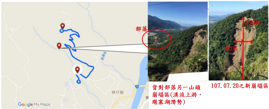
圖 2-11 建山部落背面坡地崩塌(地圖來源摘自 Google map)
