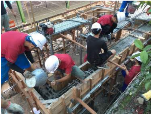
圖四、分工合作，震動棒、搗實、澆置。
