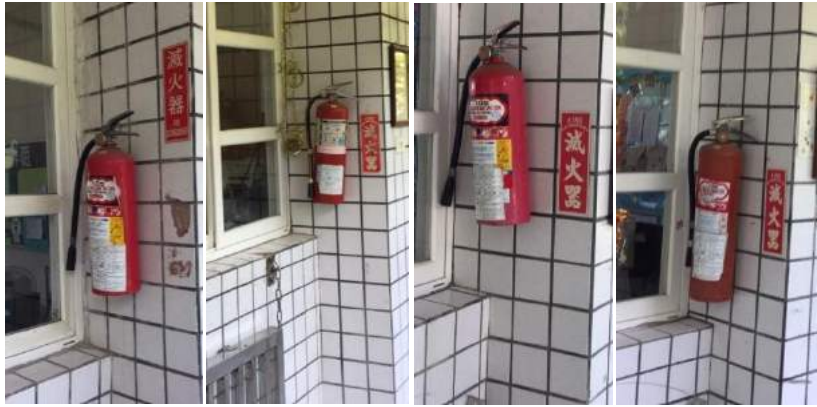
圖 1-2 設置在教室外的滅火器
