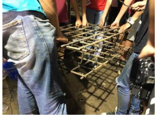
圖二、基礎綁紮完成
