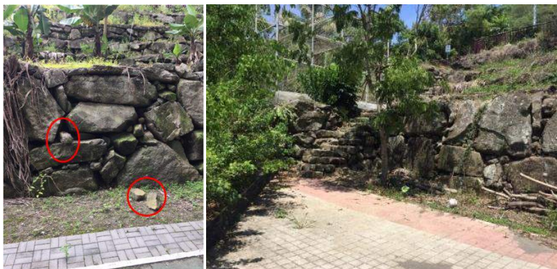
圖 1-4 校內砌石護坡、砌石階梯
