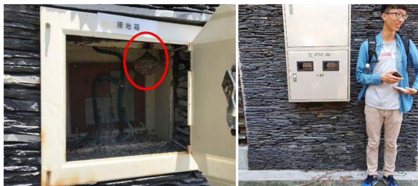
圖 1-7 電箱高度、電箱內部蜂巢
