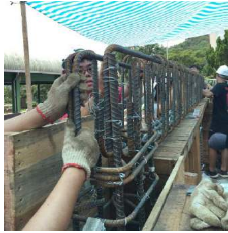
圖二、樑鋼筋及箍筋
