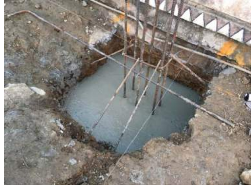
圖四、澆置完成
