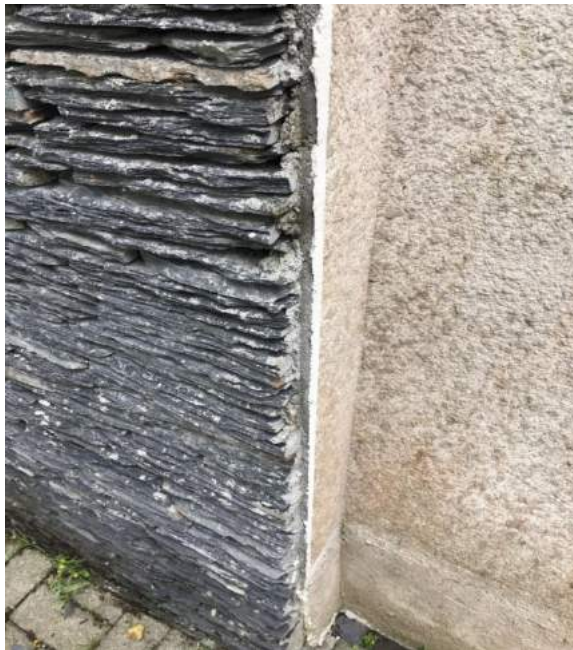
圖 1-5 結構物造型材料之鋸齒銳角
