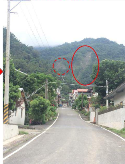
圖 2-19 一號農路坡地崩塌擴大
