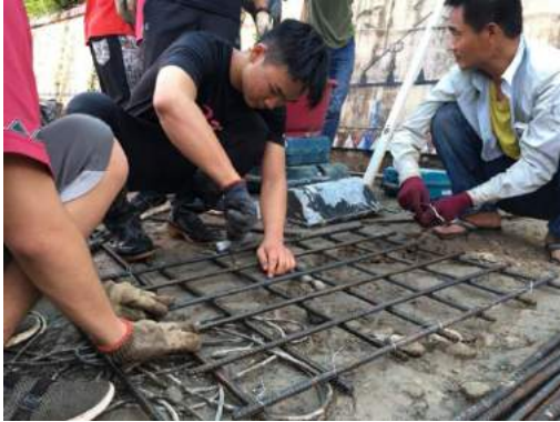
圖一、基礎鋼筋綁紮
