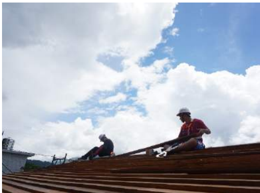
圖一、屋頂板組裝 1
