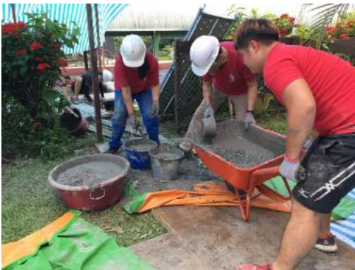
圖一、林建良主任協助同學，澆置混凝土。
