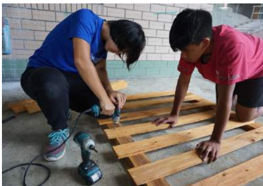
圖一、欄杆組裝
