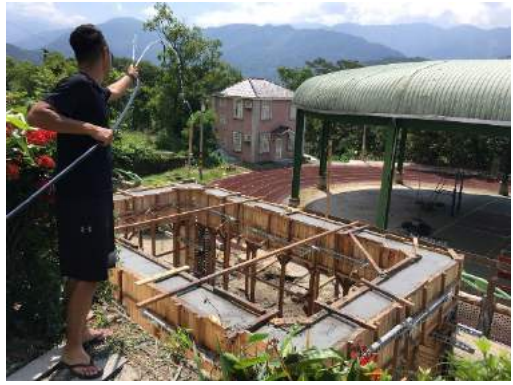
圖五、養護混凝土。
