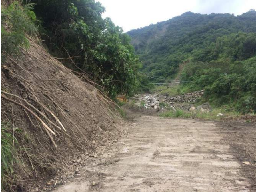
圖 2-17 建國橋附近崩塌(已經將路通到建國便橋)
