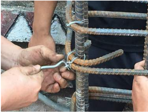
圖一、柱箍筋
