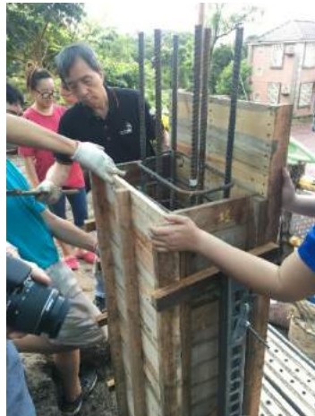
圖四、柱模板組立
