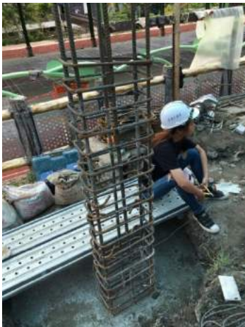
圖三、柱鋼筋完成
