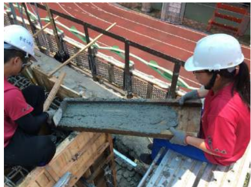
圖二、由於場地受限鷹架無法靠近模板，所以利用模板讓混凝土滑下。
