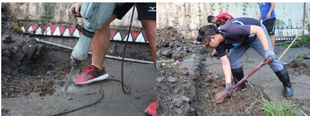
圖一、利用破碎機將原有混凝土打破 圖二、以人工方式將下部土層挖開破
