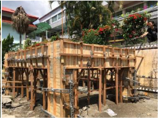
圖四、模板組裝完成
