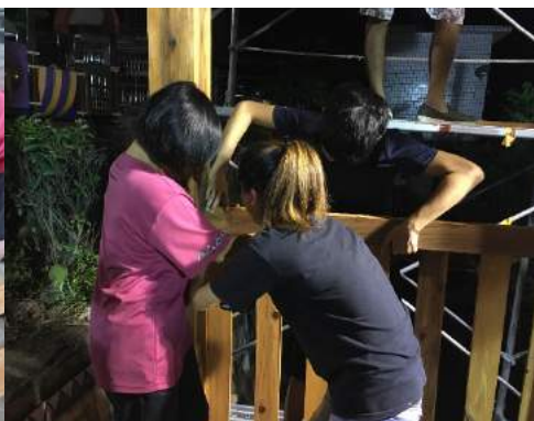
圖二、欄杆固定
