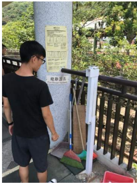
圖 1-3 三樓露臺之緩降機
