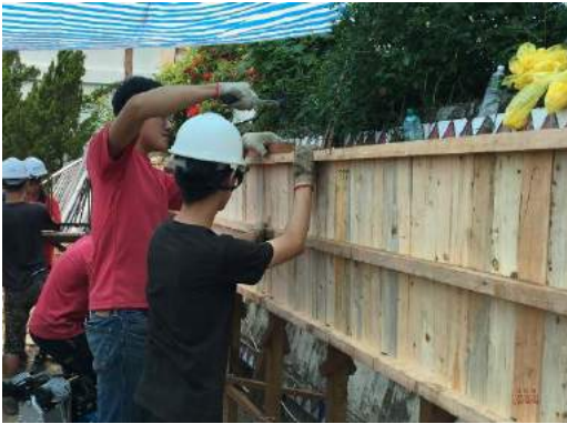
圖三、側模板固定
