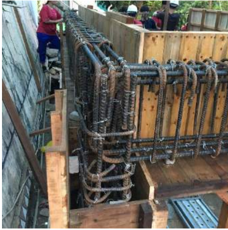
圖一、樑柱鋼筋銜接處
